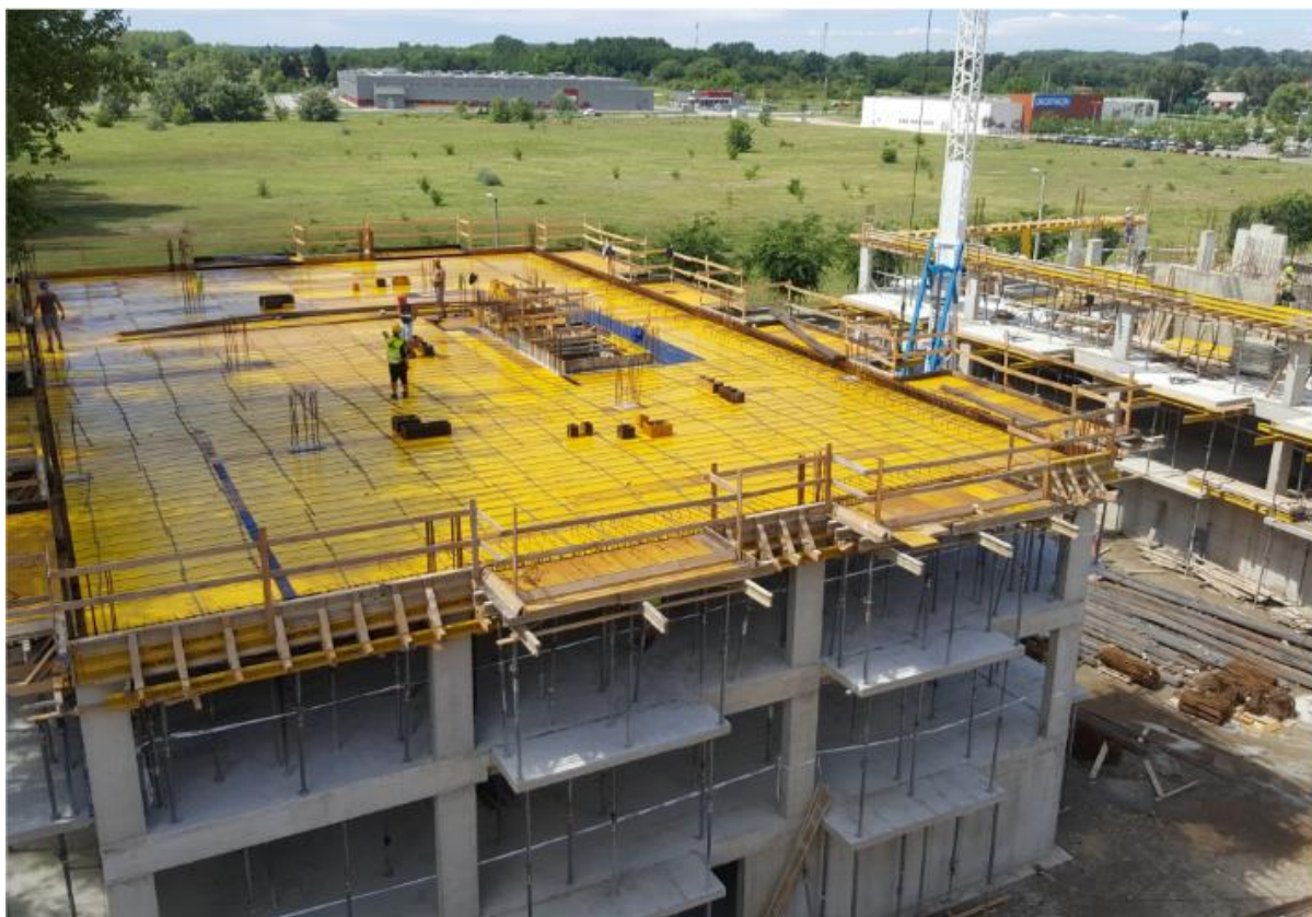
X. ábra: Boróka lakópark építése
