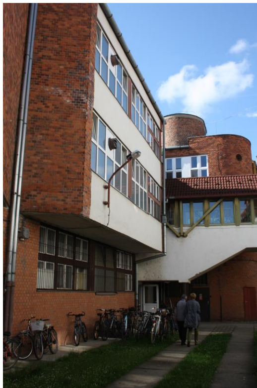
X. ábra: A Kecskeméti Szakképzési Centrum Kollégiumának felújításra váró épülete
